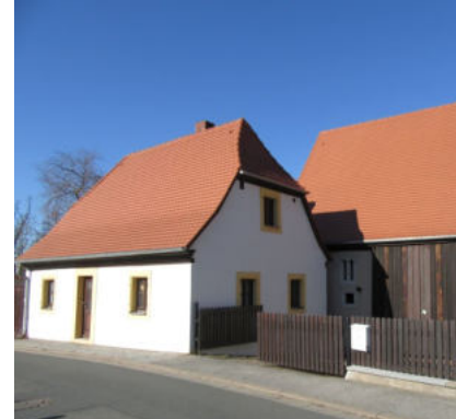
Abb.19: Wohnhaus, 1. Hälfte des 19. Jh. und älter, Hauptstr. 5
