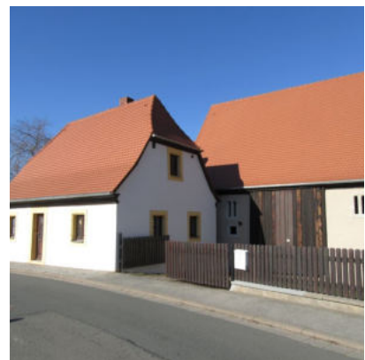
Abb.44: Haupt- und Nebengebäude, Hauptstr. 5
