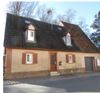
Abb.24: Mittlerer Gebäudezustand, Hauptstr. 42
